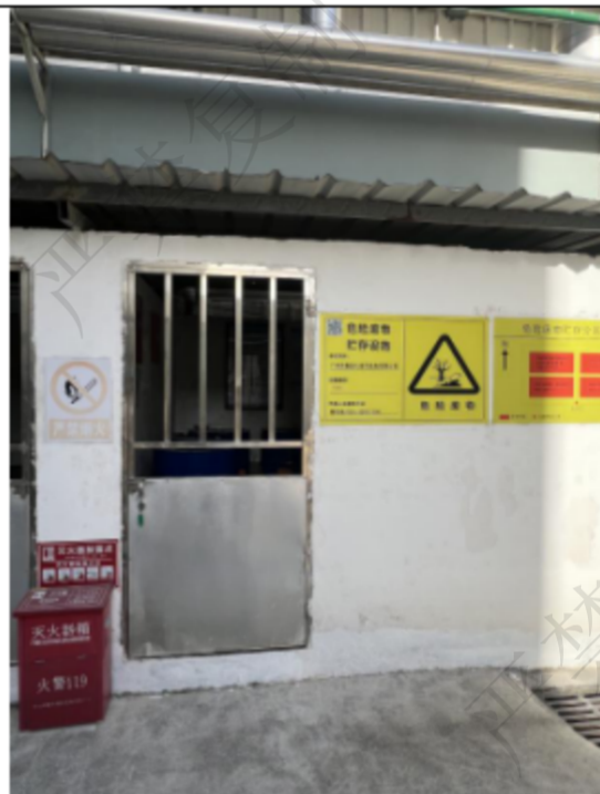
危废暂存间: WFJ-01
