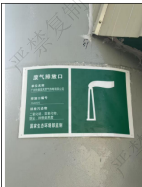
废气排放口：DA005（本项目）
