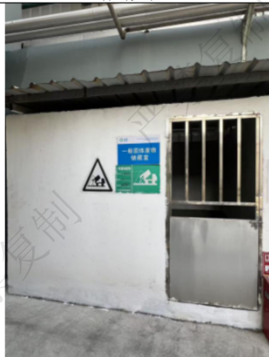
一般固废暂存间: 固-01
